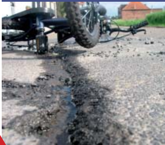
Reflexné trhliny
